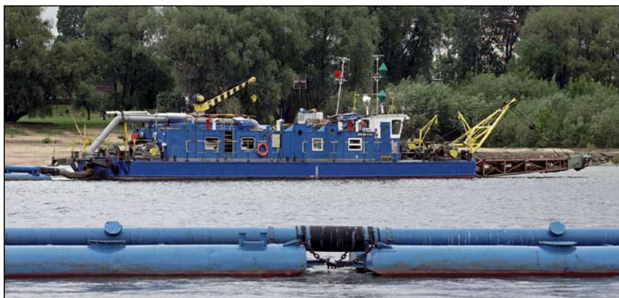
■ Dookoła stacji filtrów Grubej Kałki prowadzone są bezustannie prace pogłębiarskie. Jak to optynać?
